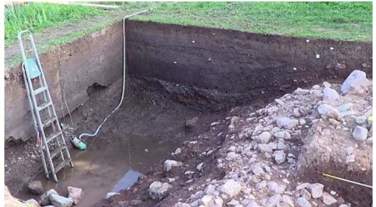
Fig.6. L'empierrement du talus est bien visible
