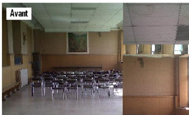
Réfection de la Salle du Chapitre
